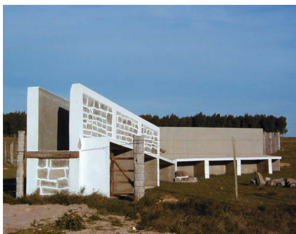
Fig. 13. Embarcadero adecuado. (Foto: INAC).
