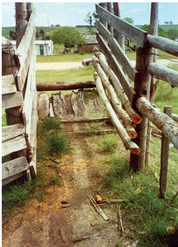
Fig. 5. Embarcadero inadecuado. (Foto: Empresa Roque Damián).
